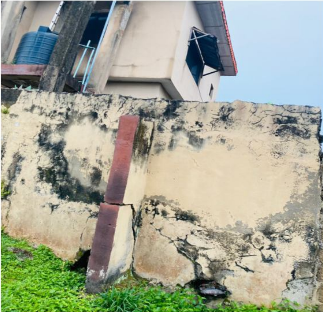
Plate 4 : Cracks
