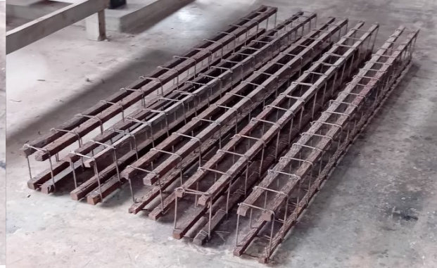
(b) Fan palm bars and steel stirrups
