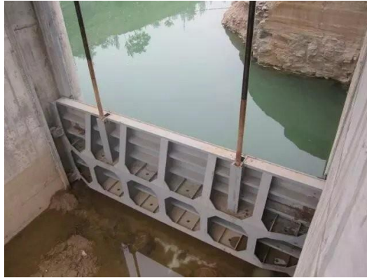
Fig. 3 Door groove embedding
