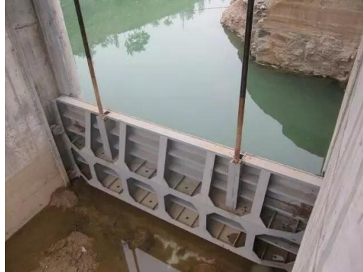
Fig. 3 Door groove embedding
